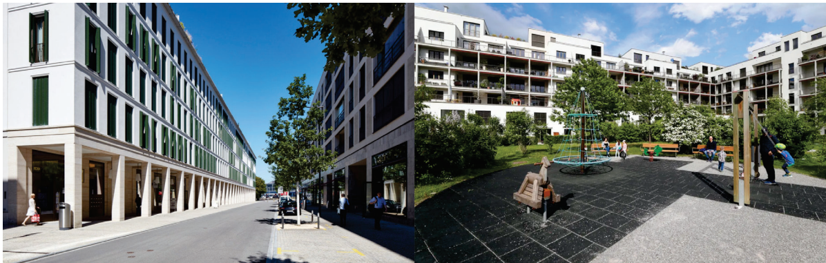
Figura 3. Vista de la Richtiarkade, calle principal del Barrio Richti. y uno de los patios interiores
