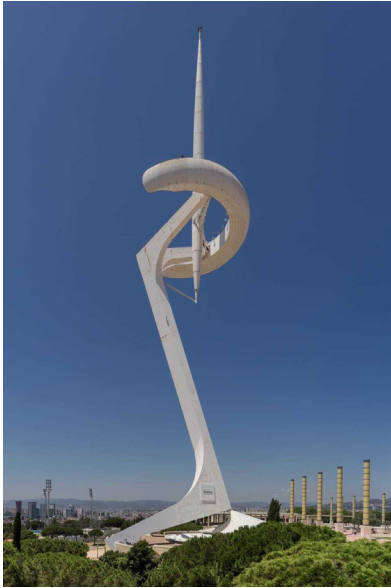
Figura 04 Torre de Comunicaciones de Montjuïc, Barcelona (1992) Imagen: Thomas Ledt
