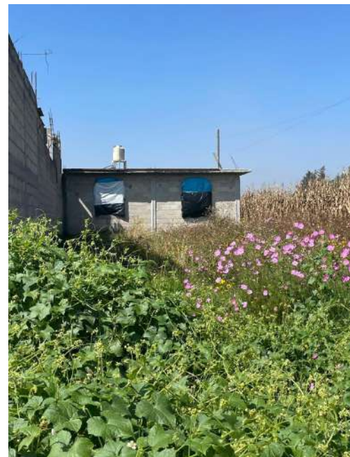
Figura 03 Viviendas en etapa inicial
