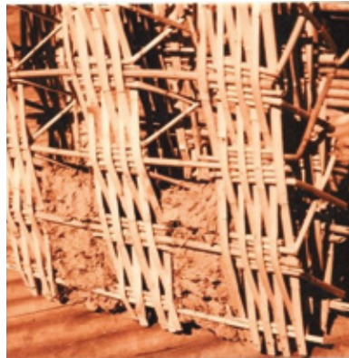
Figura 13 Entramados para muros interiores no portantes Sistema Estructural: "Nayra Uno" (Reque, 1994)
