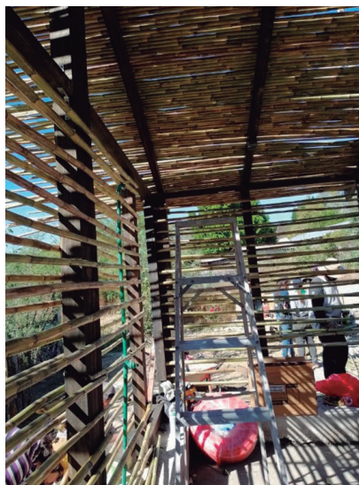
IMAGEN 05 | Sistema de muros y cubierta de pajareque
