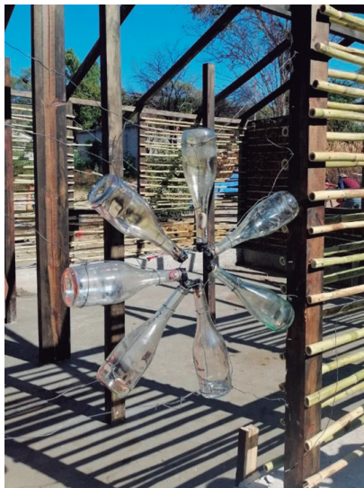
IMAGEN 04 | Estructura básica de pajareque
