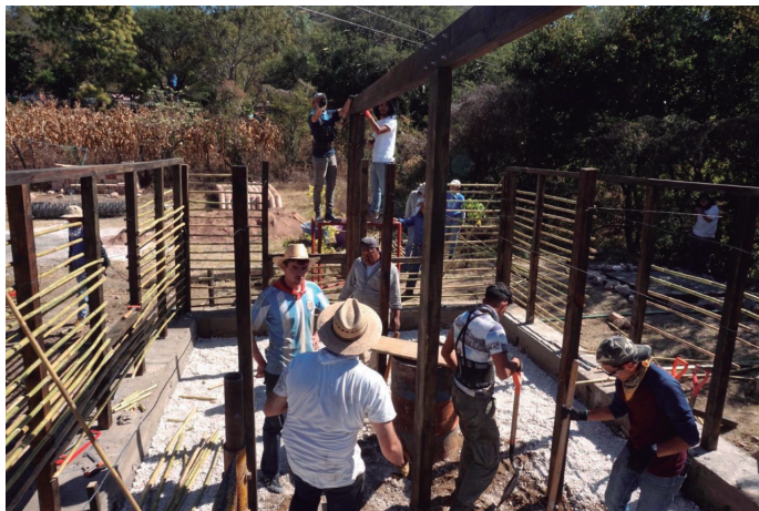
IMAGEN 06 | Materiales de muros y estructura de pajareque
