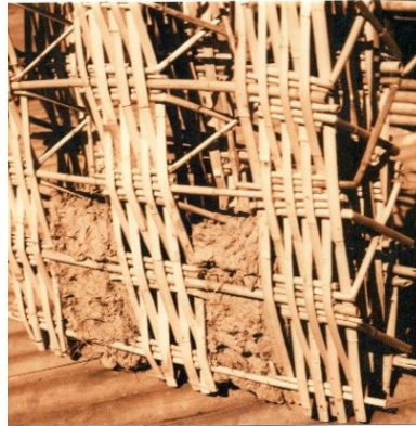
Figura 13 Entramados para muros interiores no portantes Sistema Estructural: "Nayra Uno" (Reque, 1994)
